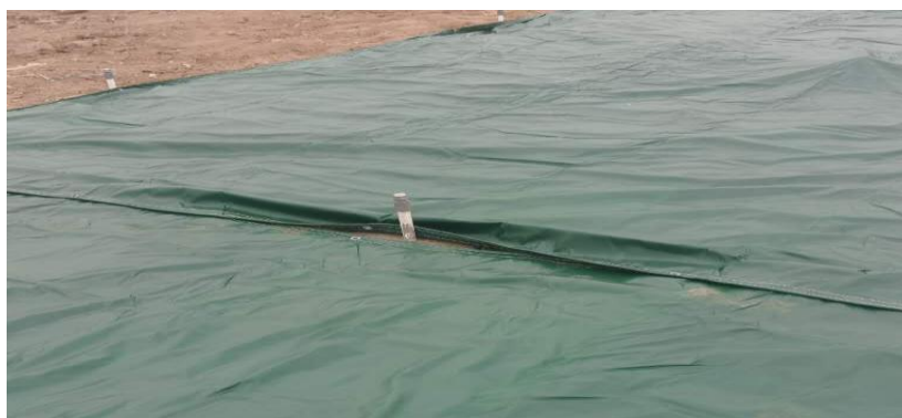
图 6.3-4 地表铺设不透水布
